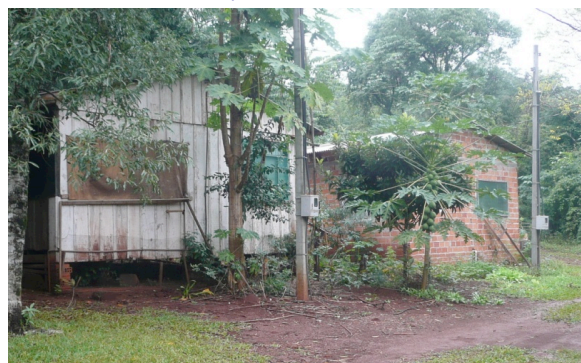
Figura 1.5.3. Residência em acampamento do reservatório de Itaipu, com melhorias (energia elétrica e parede de alvenaria) no ano de 2010.
