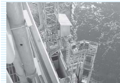
Figura 6.1.6 - Elevador de peixes na barragem da UHE Funil, no rio Grande (Foto: V. C. Torquato).
