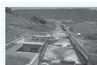
Figura 6.1.8 - Escada de peixes da barragem do reservatório de Lageado (Luiz Eduardo Magalhães), rio Tocantins (Foto: C. S. Agostinho).
