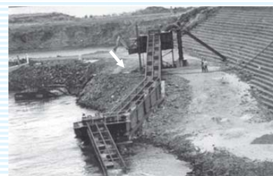
Figura 6.1.5 - Modelo experimental de escada a jusante de Porto Primavera. Seta mostra o local de carregamento do caminhão (Foto: J. H. P. Dias).
